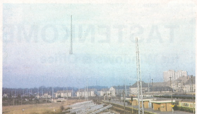
Setzen der Masten auf Rostocks Hauptbahnhof FOTOS: SCHIMLER
